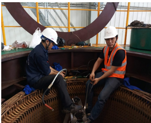
Bảo dưỡng động cơ bơm nhà máy nhiệt điện 2MW./ Maintenance and repair the pump motor of the thermal power plants
