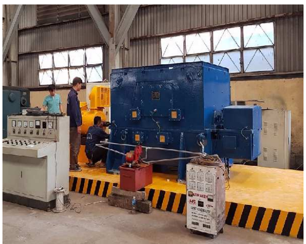
Bảo dưỡng máy phát 4194KVA – Dầu Khí Maintenance the generator 4194kVA – Oil and gas sectors
