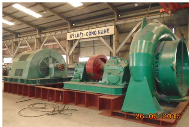
Bảo dưỡng tổ hợp máy phát thủy điện 1,5MW/ Maintenance and assembly hydroelectric generator 1.5MW
