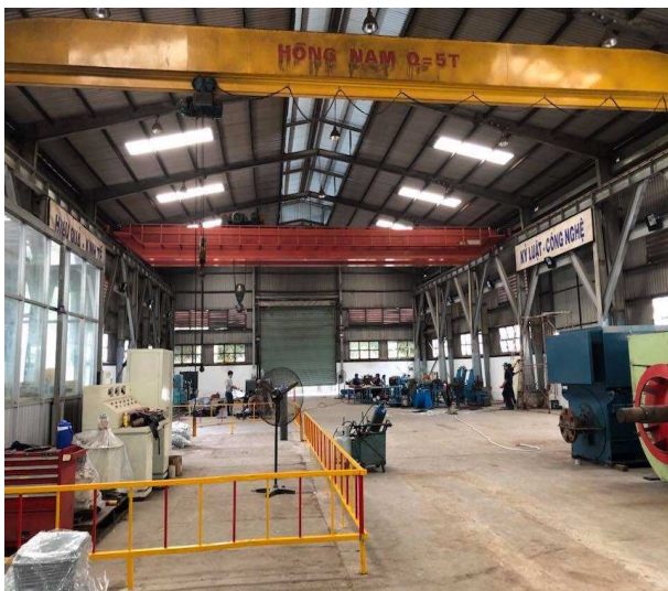
Xưởng bảo dưỡng sửa chữa - Diện tích 1200m 2 Maintenance - repair workshop - Area 1200 m 2
