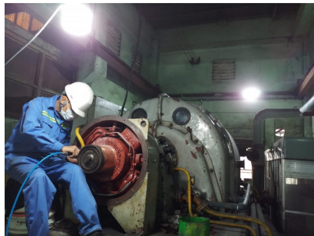
Thay mới cổ góp và bộ dây rotor kích từ máy phát 3,6MW/ Replace the commutator and the rotor coil of the generator 3.6 MW
