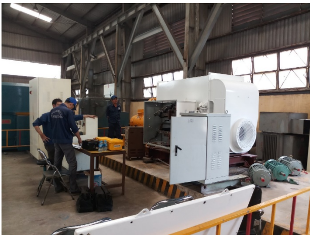
Thay mới bộ dây Stato máy phát Leroy 344KVA cho tàu biển/ Replace the stator coil of the generator – Leroy Somer 344kVA
