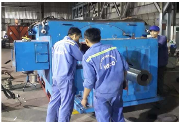
Bảo dưỡng động cơ 4000kW-6kV/ Maintenance for medium voltage Motor 4000kW-6kV
